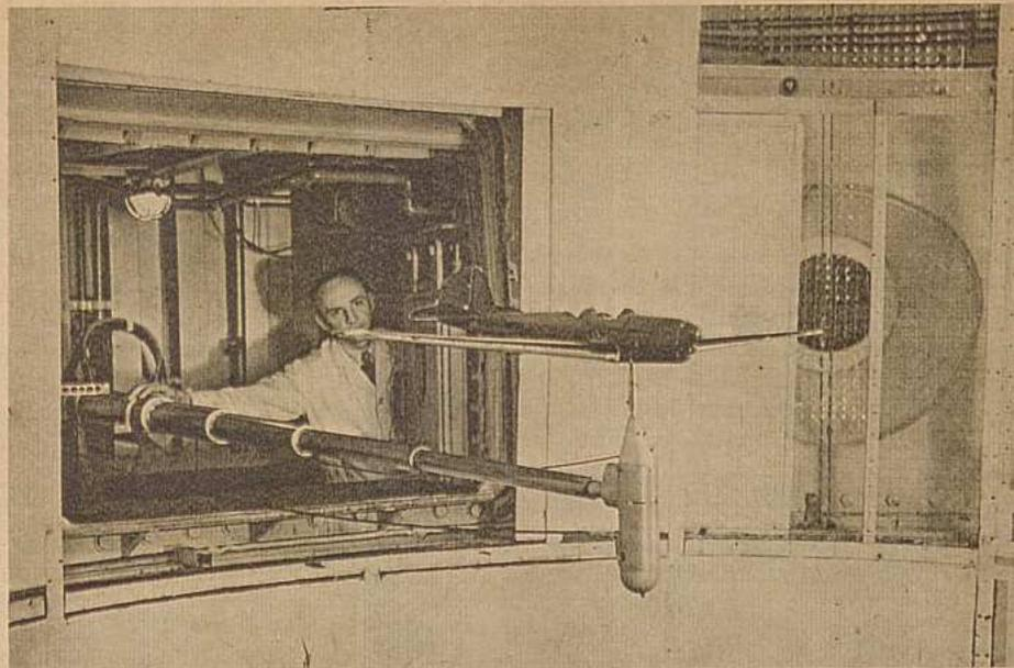
**B**eginn der Trudeluntersuchung: Das Flugzeugmodell (Bild links) wird mit einem Haltearm in den Trudelkanal eingesetzt. Sobald das Gebläse an der Decke des Kanals angeblasen wird, hebt sich das Modell selbsttätig von dem Haltearm ab und trudelt frei im künstlichen Windstrahl nach unten
