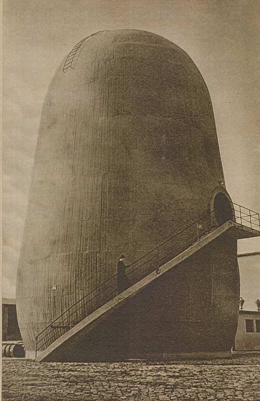
Der Blick auf die Düse des Windkanals, vor der die Flugzeugfläche aufgehängt ist, läßt deutlich die Größe der Anlage erkennen. Die von dem Modell nach unten führenden Drähte laufen in ein Wasserbecken und sollen etwaige störende Vibrationen beseitigen
